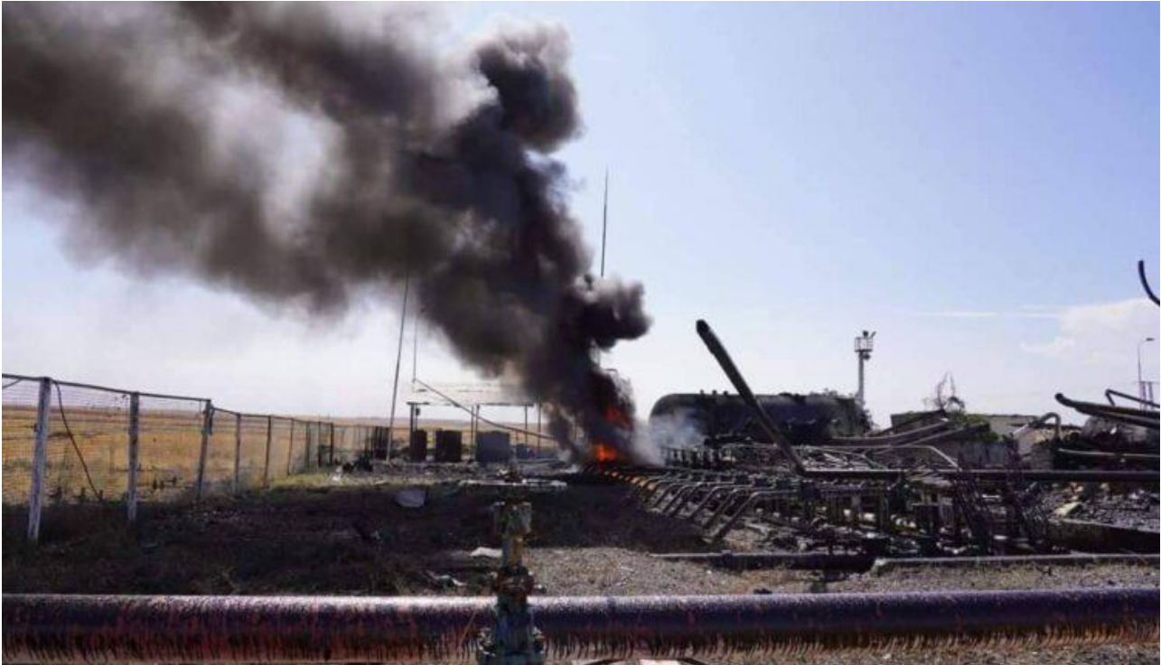
الصورة رقم (5) - جانب من الأضرار التي لحقت بمنشأة غاز وكهرباء السويدية في ريف المالكية/ديريك، جراء الهجمات التركية بتاريخ 5 تشرين الأول/أكتوبر 2023. المصدر: وكالة "نورث برس".
