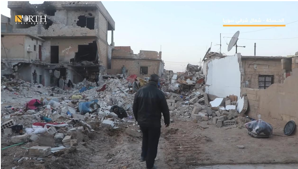
صورة رقم (28) - "عطية عبد الرحمن" من سكان حي الغويران يفحص حطام منزله، وتظهر الصورة آثار استخدام الجرافة عند اقتحام المنزل. مصدر الصورة .
