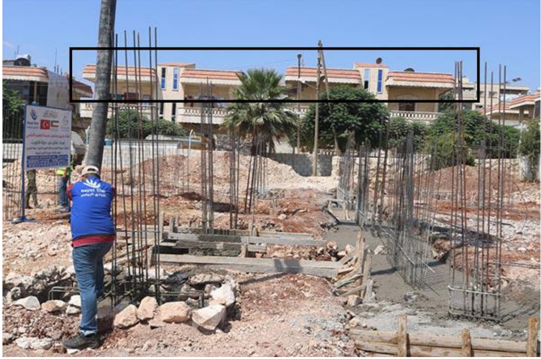
صورة رقم (5) - جانب من عمليات بناء الأولى لمدرسة "إمام و خطيب" على أنقاض مبنى الاتحاد الأيزيدي. المصدر: موقع جمعية الأيادي البيضاء.
