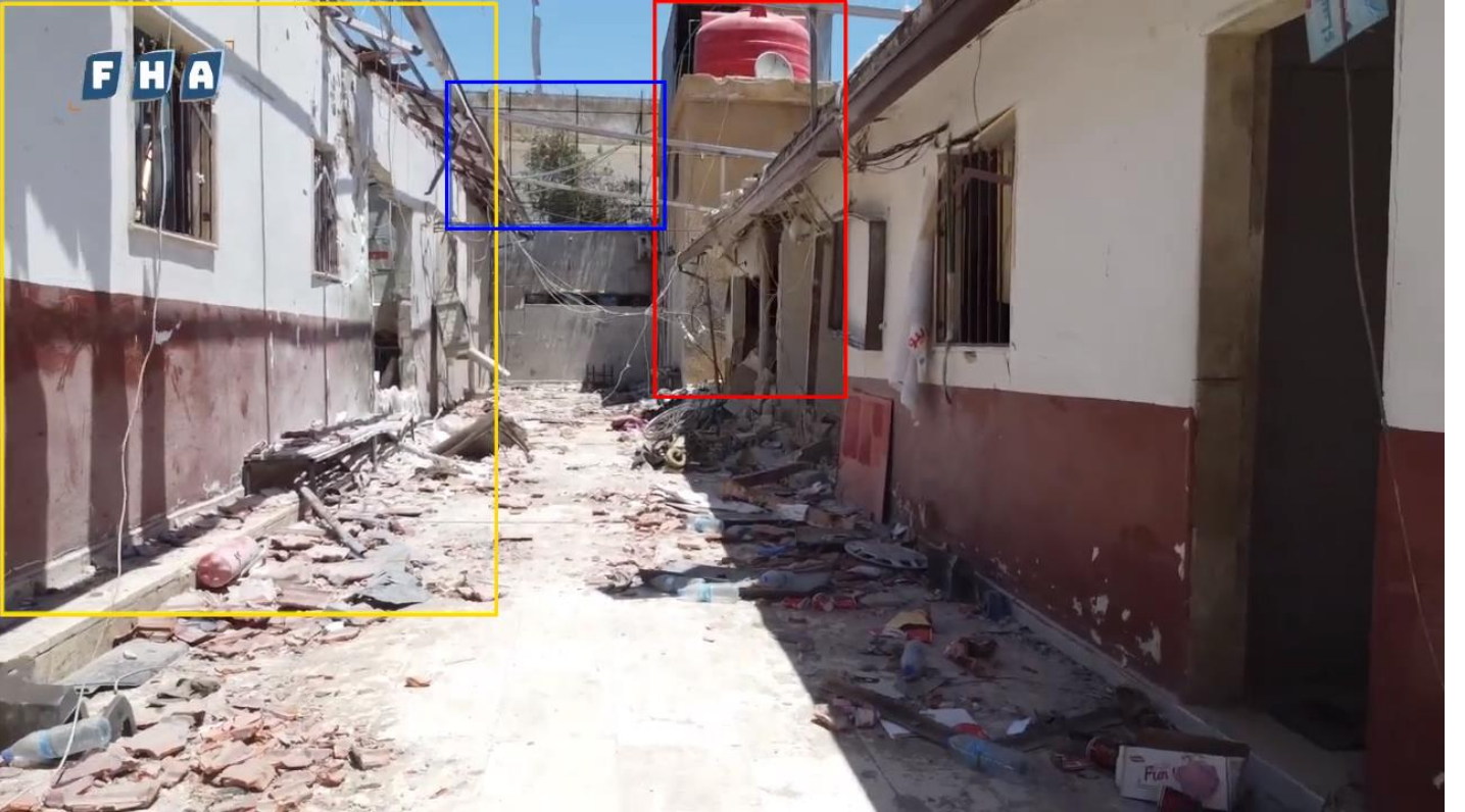
صورة رقم (17) - صورة مأخوذة من مقطع فيديو، تُظهر الضرر الذي حصل في موقع سقوط الصاروخ الأول.
