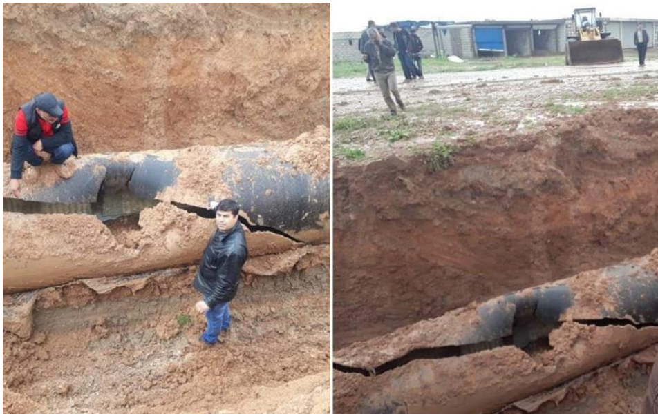
صورة رقم (3) - صورة تظهر الخط الرئيسي لنقل المياه من محطة علوك، والذي خرج عن الخدمة بالقرب من قرية أم الكيف، عقب تعرضها للقصف بقذائف المدفعية والهاون من قبل القوات التركية وفصائل الجيش الوطني السوري. مصدر الصورة: صفحة الحسكة على موقع فيس بوك.
