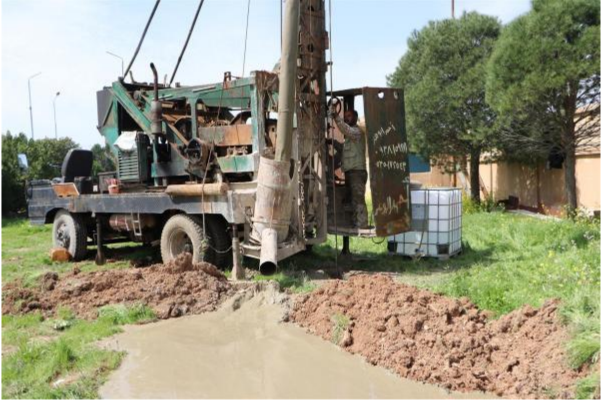
صورة رقم (13) - تظهر الصورة جانب من اعمال بدء تنفيذ مشروع انشاء محطة جديدة للمياه في منطقة "الحمة" غربي الحسكة كبديل لمحطة مياه "علوك"، بتاريخ 24 آذار/مارس 2020. مصدر الصورة: وكالة أنباء "هاوار" المقربة من الإدارة الذاتية.
