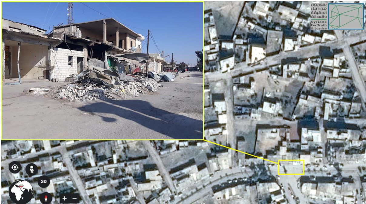
صورة رقم (8) - صورة تظهر الصورة في الأعلى وإلى اليسار الفرن الذي وقع التفجير بجانبه وقد تم ترميم جدار الفرن حديثاً كما يظهر الركام والمحللات بجانب الفرن متضررة، وتظهر الصورة في الخلفية موقع الفرن في بلدة سلوك.
