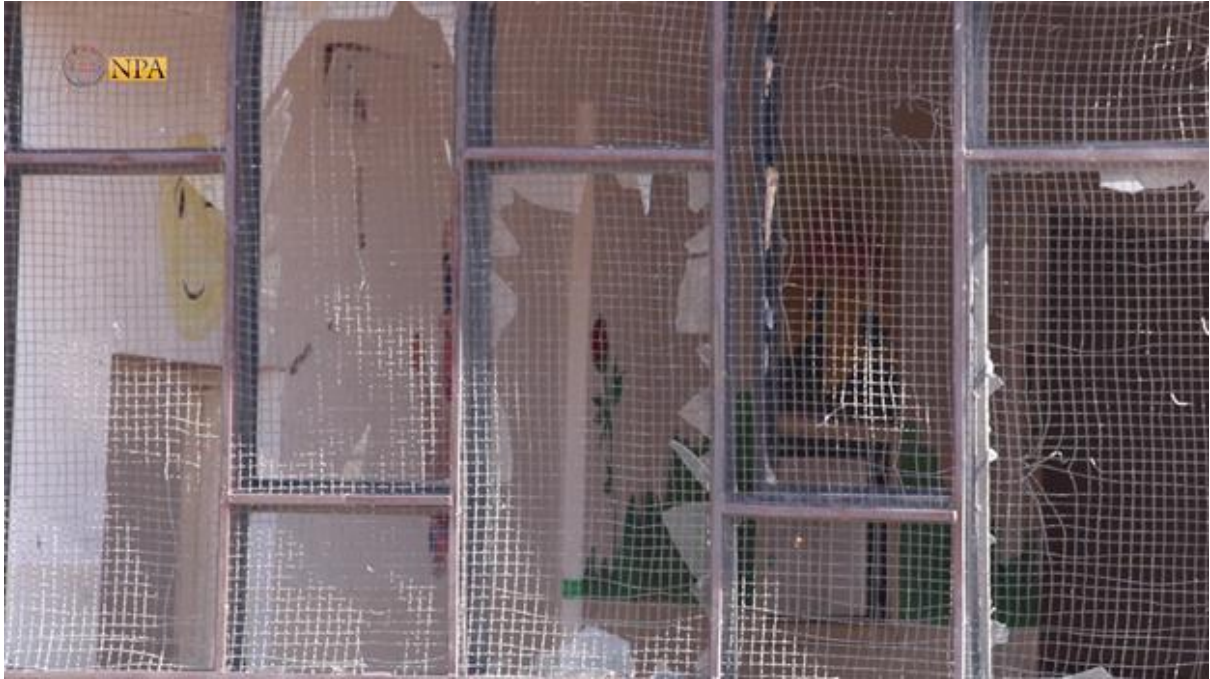
صورة رقم (7) - تُظهر أضرار لحقت بإحدى الصفوف من الداخل.
