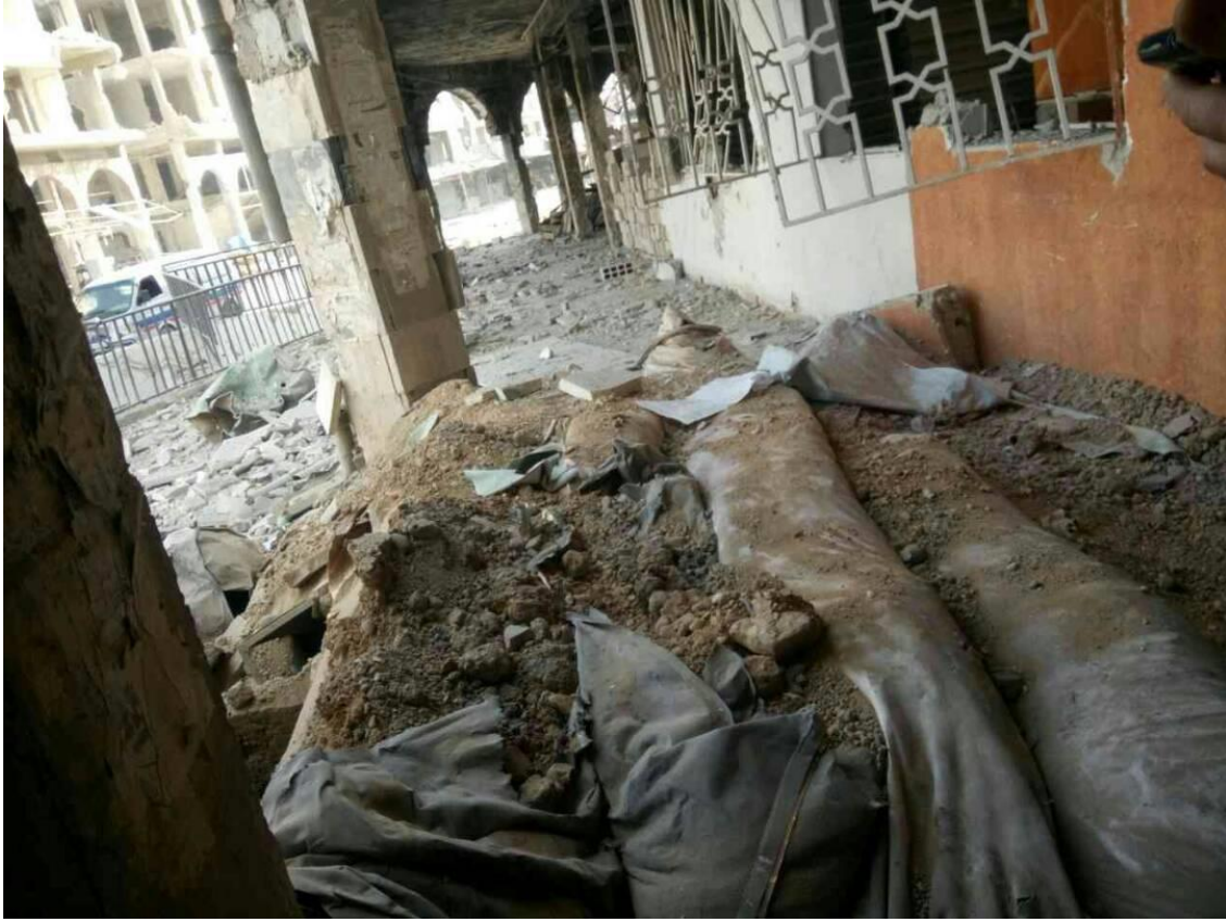
صورة خاصة بسوريون من أجل الحقيقة والعدالة، تظهر جانباً من الدمار الذي لحق بمبنى المجلس المحلي لمدينة دوما، إثر القصف الجوي الذي تعرض له بتاريخ 6 شباط/فبراير 2018
