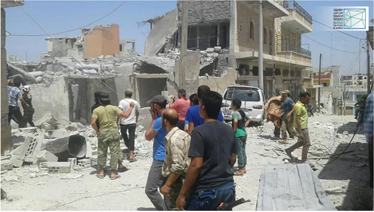
صورة خاصة بسوريون من أجل الحقيقة والعدالة تظهر منزل الشاهد "جاسم الخالد" في بلدة تفتناز عقب تعرضه للقصف بتاريخ 10 حزيران/يونيو 2018.
