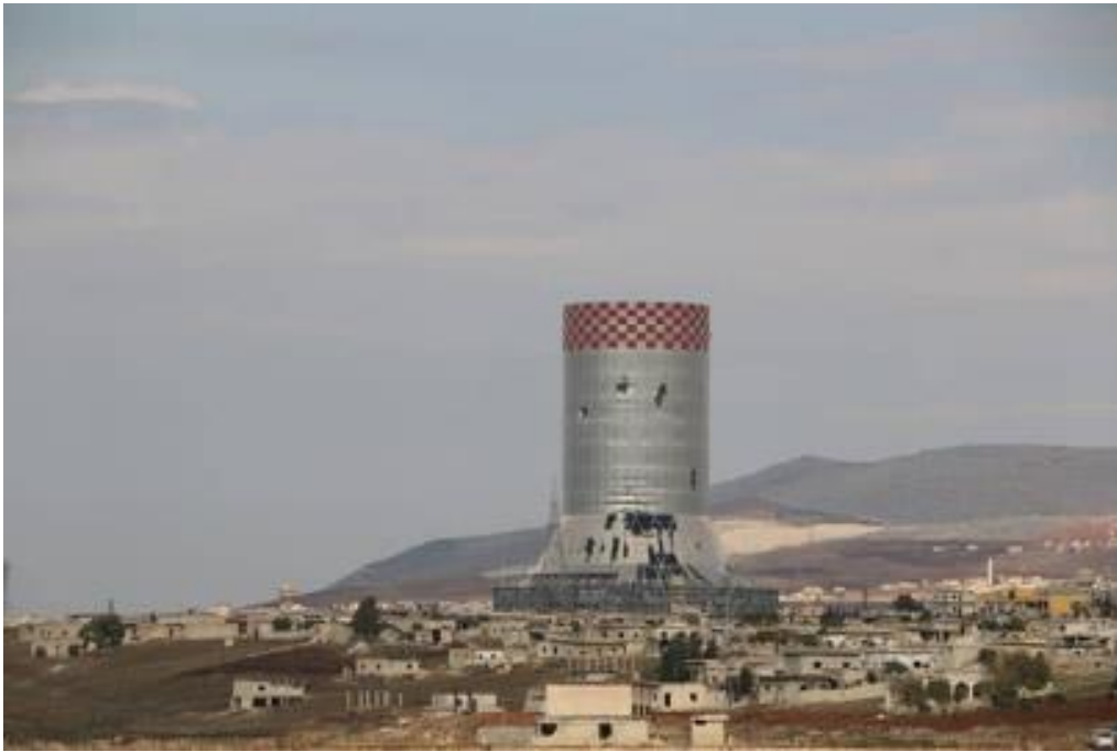
صورة تظهر جانباً من محطة كهرباء زيزون بعد الاستيلاء عليها ونهبها من قبل الحزب الإسلامي التركستاني، مصدر الصورة: ناشطون إعلاميون.
