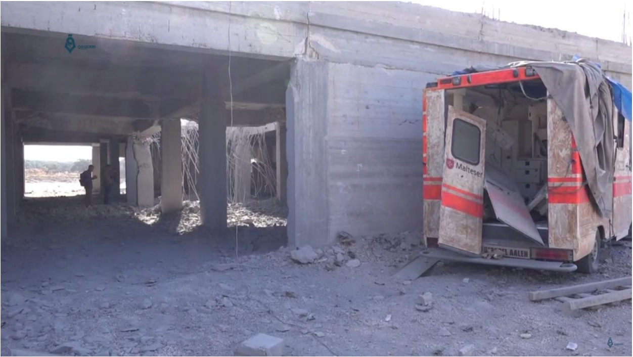
صورة توضح آثار الدمار التي لحقت بإحدى عربات الإسعاف ومدخل المشفى في الطابق الأرضي ويظهر في الخلف الفجوة التي حصلت في الأسقف مكان نزول الصاروخ مقتطعة من فيديو شبكة "أخبار قاسيون"
