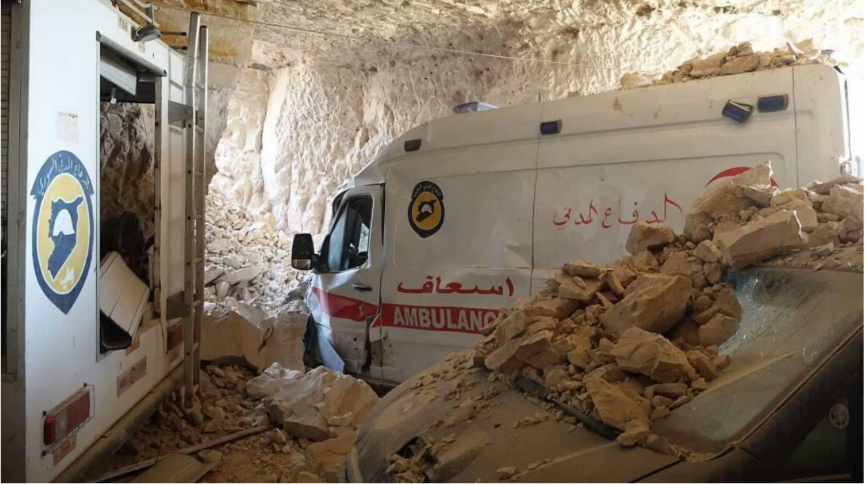
صور توضح آثار الدمار الذي لحق بالمشفى ومركز الدفاع المدني بعد الهجمة الثانية - المصدر نشطاء إعلاميون
