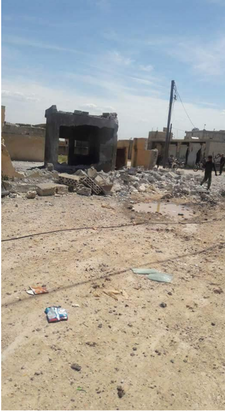
صورة تظهر جانباً من الدمار الحاصل في المركز الطبي في بلدة كفرسجّنة، وذلك إثر القصف الذي تعرض له بتاريخ 25 نيسان/أبريل 2018، مصدر الصورة: المجلس المحلي في بلدة كفرسجّنة .
