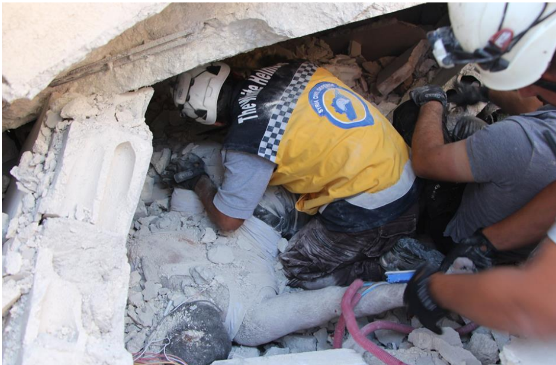
صورة تظهر جانباً من محاولات فرق الدفاع المدني انتشال وإنقاذ العالقين من تحت الأنقاض في مدينة سرمدا، وذلك إثر الانفجار الذي هزَّ المدينة بتاريخ 12 آب/أغسطس 2018، مصدر الصورة: الدفاع المدني السوري في محافظة إدلب .
